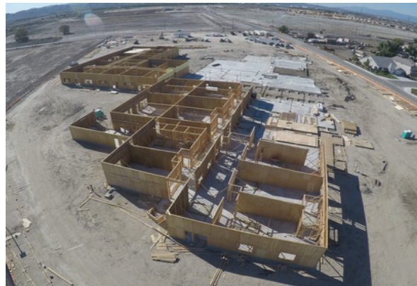
Area A-D Framing
