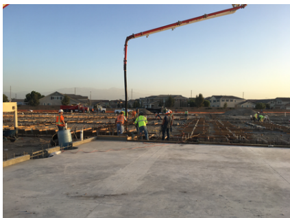
Area F-G Footing Pour
