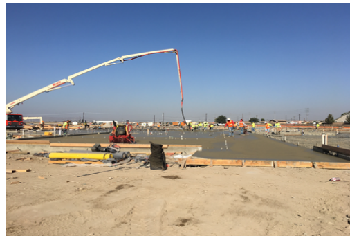
Area A-D Slab Pour
